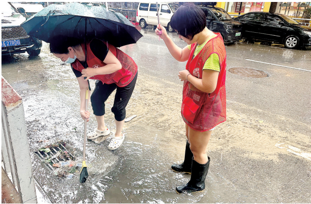
清理排水口堵塞物
