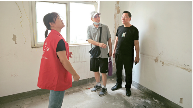
及时为居民解决家中漏水问题
