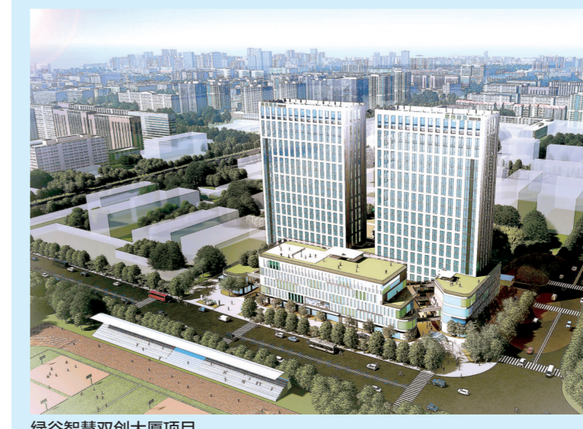
绿谷智慧双创大厦项目
