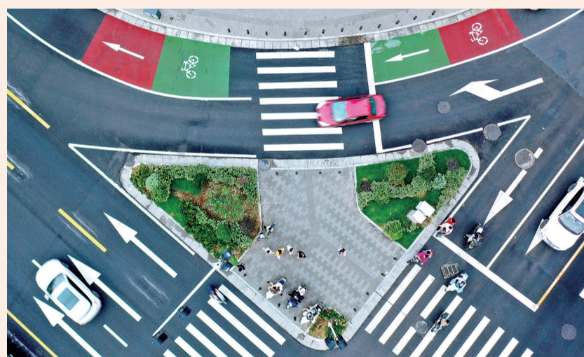
道路综合改造全面完成,营造整洁舒适的城市环境
