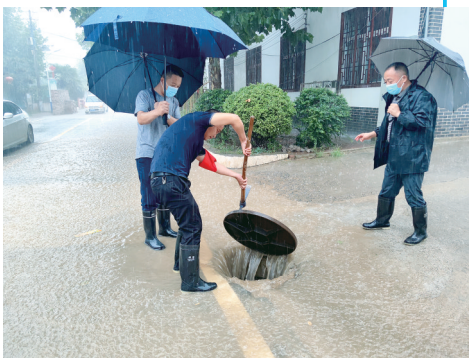
工作人员掀起井盖快速排出积水
