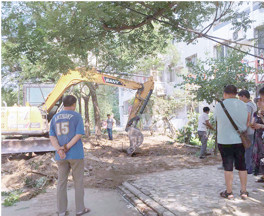
正在改造施工中的金祥社区
