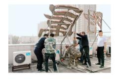
了科学的拆除方案,先用气割机将标识招 牌的字体进行逐个切割后,再由工人从楼 顶进行集中的清运,预计拆除工作需要10 天左右完成。
