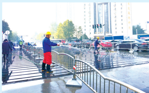
嵩山南路地铁站工地四周定时洒水
