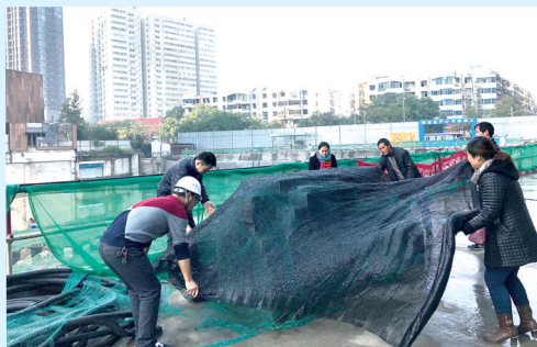
铭功路街道工作人员在工地完成覆盖工作
