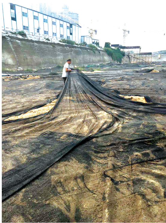
人和路街道对工地黄土裸露进行覆盖
