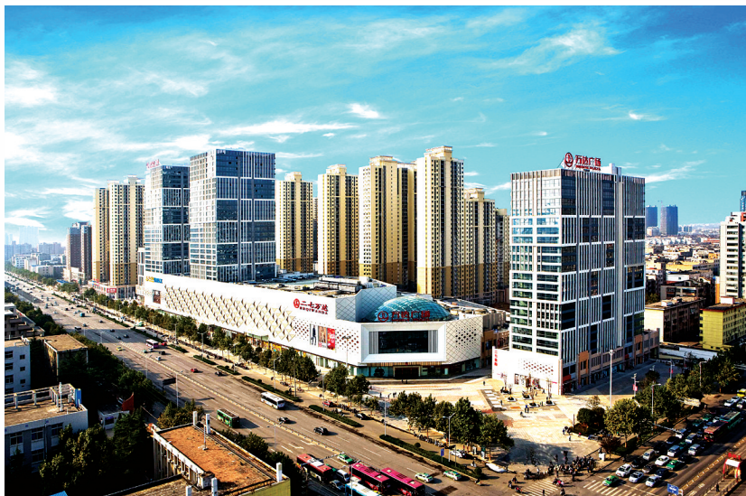
二七万达广场城中村改造项目改善人民生活提高城市品位
