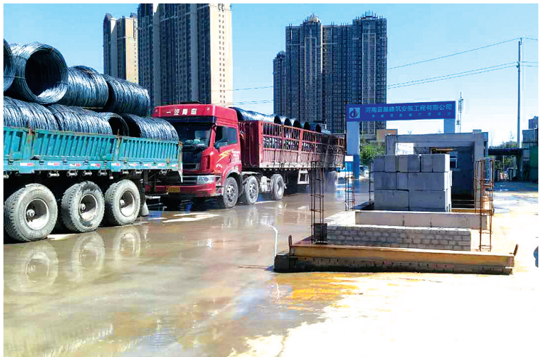
建筑工地对车辆进行洒水
