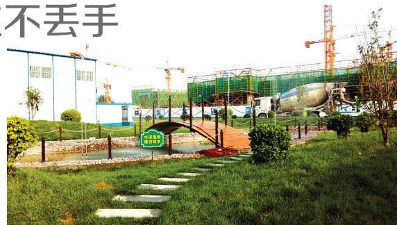
张寨安置房一标段建筑工地
