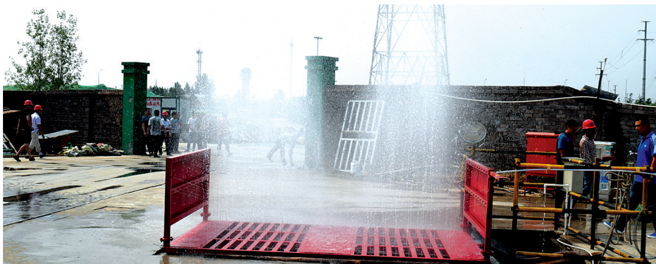
侯寨乡辖区建筑工地配备喷淋设备
