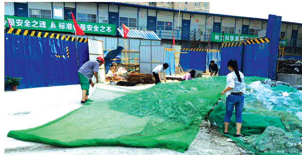
人和路街道对建筑工地铺设防尘网
