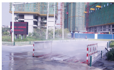
铁道京广家园在建项目
