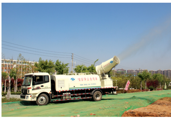
雾炮车在工地治理扬尘
