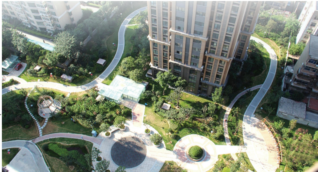
拆迁改造后的路砦新区
