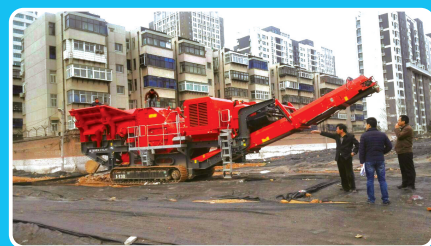
王立砦拆迁工地的鄂破机能粉碎建筑垃圾
