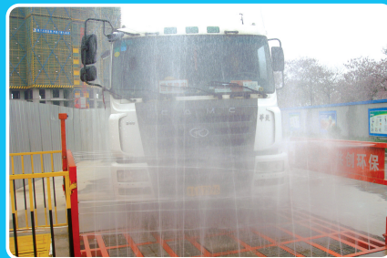
工地严格按照标准冲洗进出车辆轮胎
