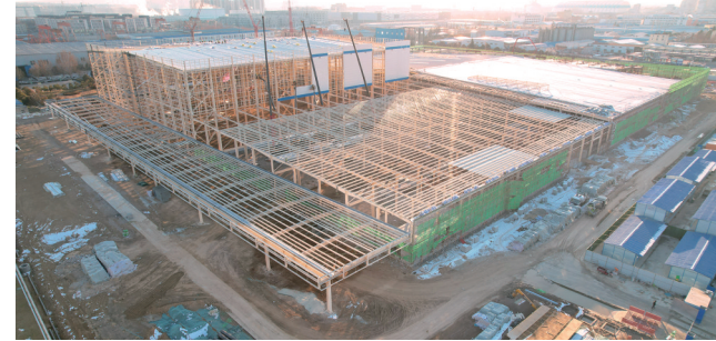
康师傅饮品中原区域总部项目现场施工图
