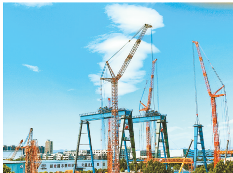
新大方重工出口印度的首条高铁550T提梁机正在拼装调试中
