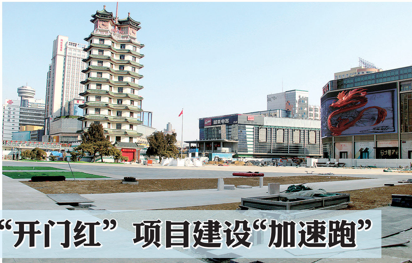
二七广场主广场铺装已基本完成
