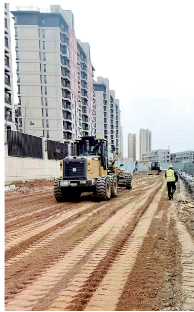
二七经开区思源路施工现场
