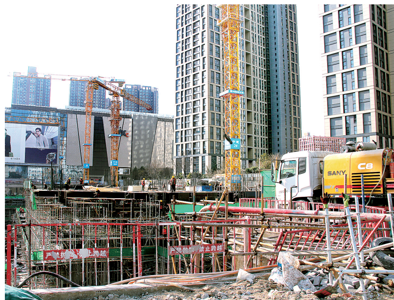
华润万象城二期项目工地施工现场
